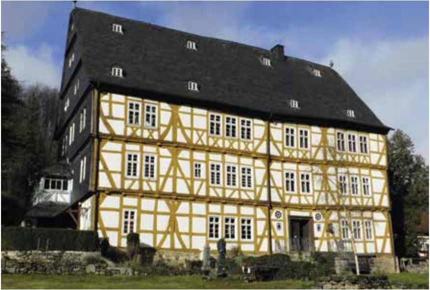
Das in den Jahren 1670 – 1679 im Auftrag des Landgrafen Georg III. errichtete „Große Haus“ im hessisch-fränkischen Fachwerkstil.
