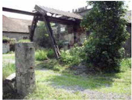
Oben: Gebäude-Relikt im alten Gipstagebau am „Dockel“. Unten: Stillgelegtes Steinsägewerk an der Straße nach Vasbeck.
