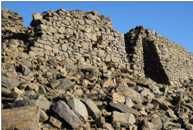
Die aktuell noch vorhandene Restmauer der Alt-Bericher Klosterkirche.
