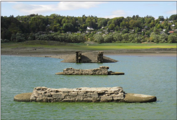
Pfeilerreste der Bringhäuser Brücke.
