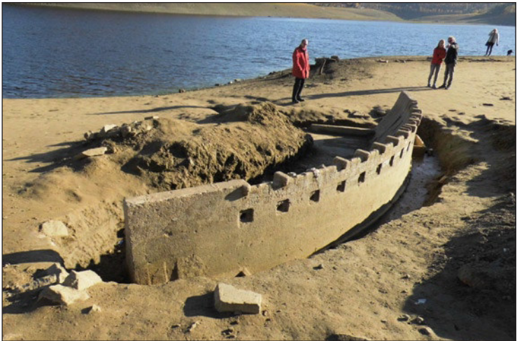
Das im Jahr 1910 zu Versuchszwecken erbaute Sperrmauer-Modell an der „Bericher Hütte“.
