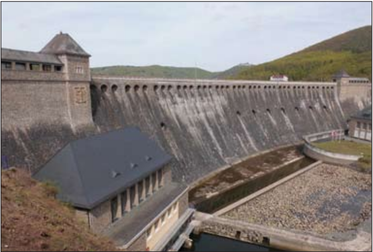
Die zwischen 1908 und 1914 errichtete Edertalsperre bei Hemfurth.
