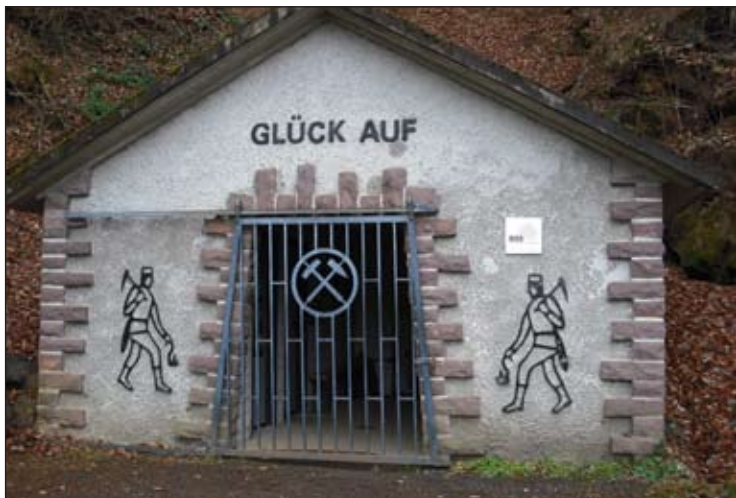
Eingang zum Besucherbergwerk „Bertsch“.
