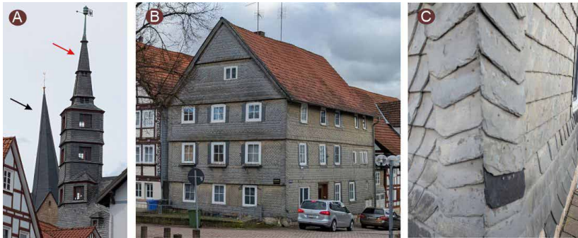
Abb. 5.2: Dachschiefer in Korbach; links: Rathausturm (roter Pfeil) und St. Kilian (schwarzer Pfeil); Mitte und rechts: Haus des Dachdeckermeisters Urff).
