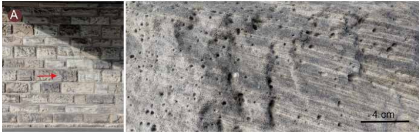
Abb. 7.6: Mittlerer Buntsandstein: Bahnunterführung Eidinghäuser Weg, Dünensedimente wurden als Werkstein verwendet.
