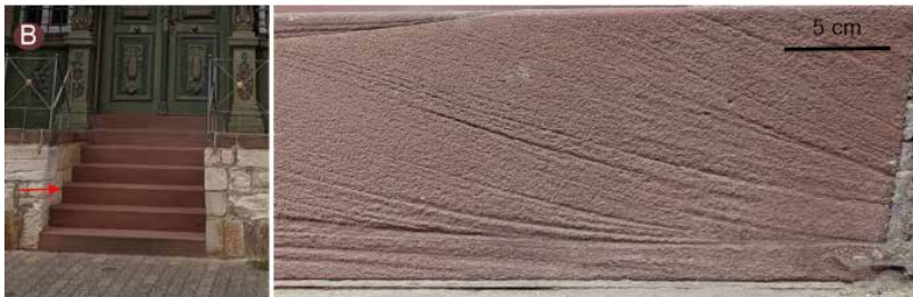
Abb. 7.3: Mittlerer Buntsandstein, Treppenstufe des Hartwigschen Hauses
