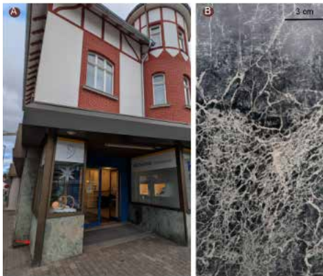
Abb. 9.2: Fassadenverkleidung aus Serpentinit.
