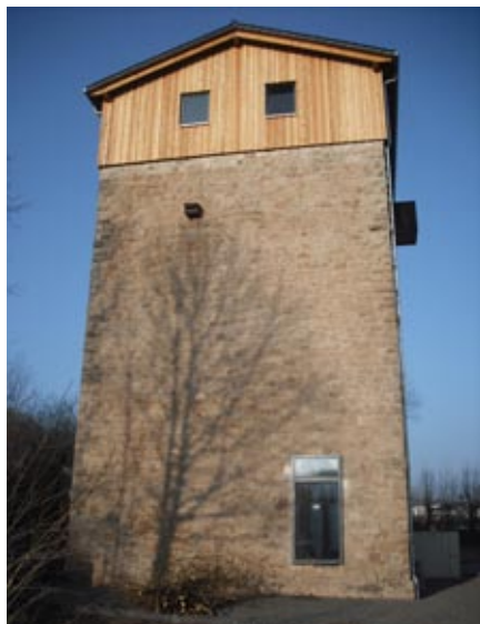
Der von Stadt Korbach sanierte, zum GeoFoyer ausgebaut Kalkturm.
