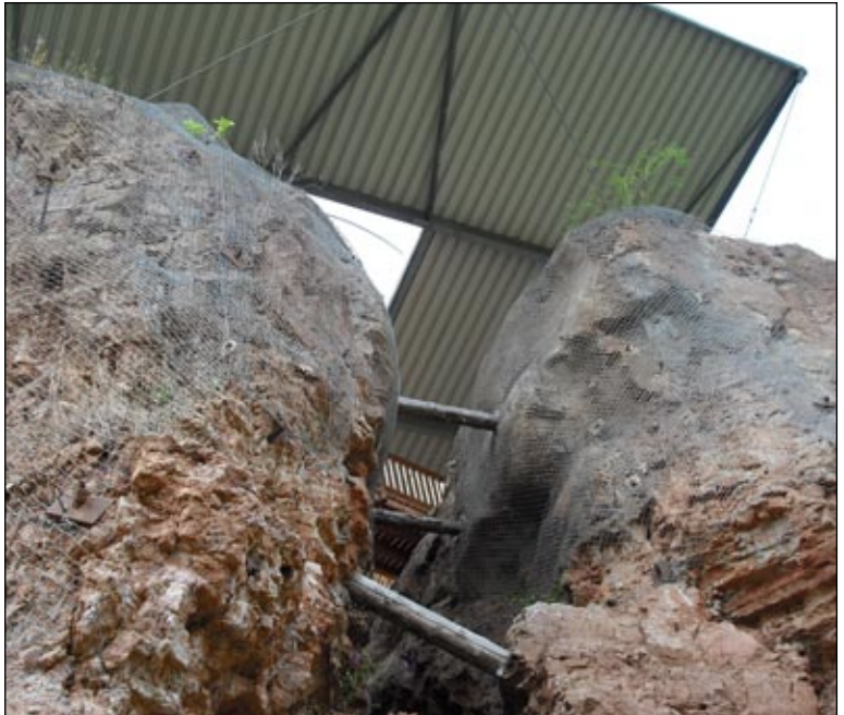
Blick in die Spalte von unten (Foto: Panek).
